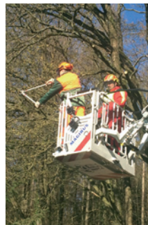
Motor „STOPP“ bei Sägearbeiten im Rettungskorb
